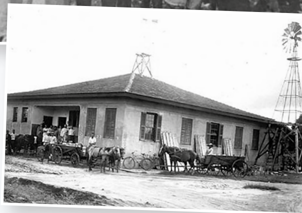
Segunda fábrica de laticínios, construída na década de 1940
