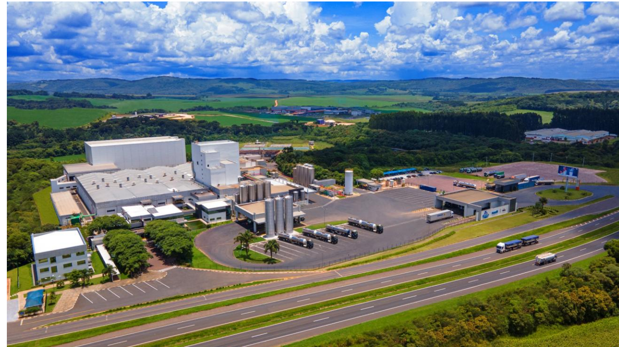
Unidade industrial de leite da Unium em Castro
