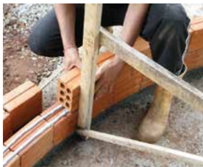
Colagem dos tijolos com argamassa polimérica
