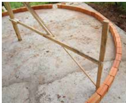
Compasso de madeira para dar verticalidade às paredes
