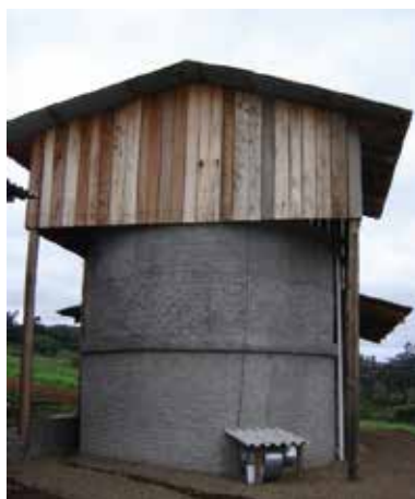
Figura 2 – Silo secador/armazenador (família Anselmini – Município de Barão/RS)
