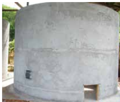
Silo após a colocação do emboço
