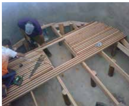
Construindo o fundo em madeira
