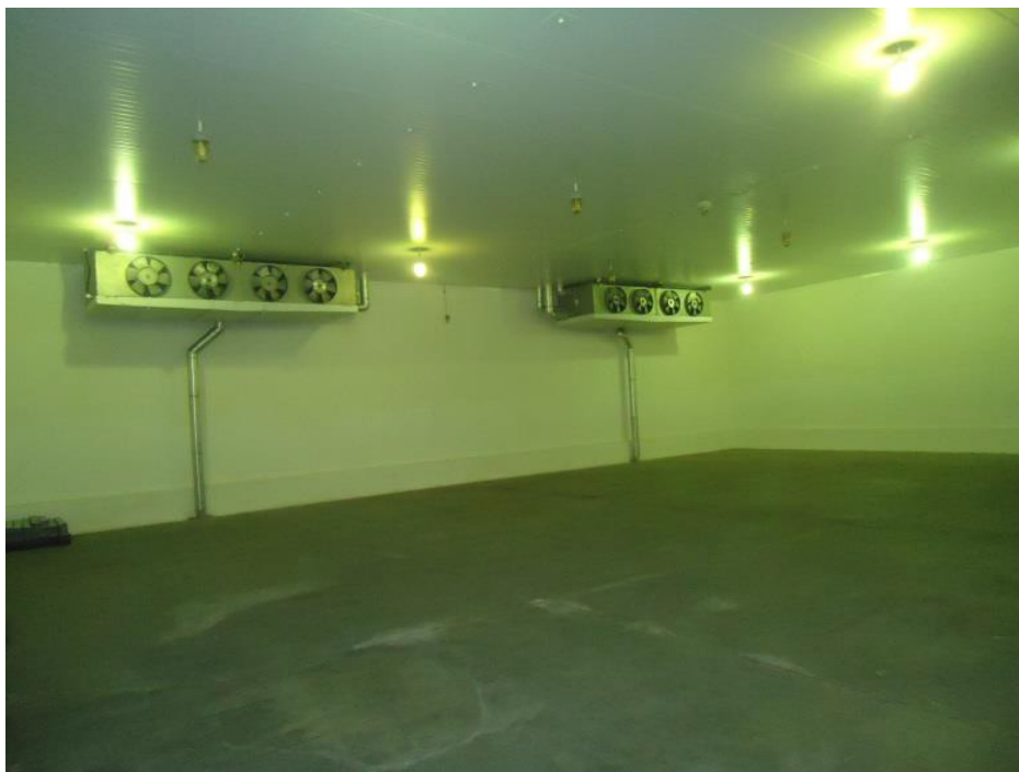
Armazém 1 - Vista interna de uma das câmaras.
