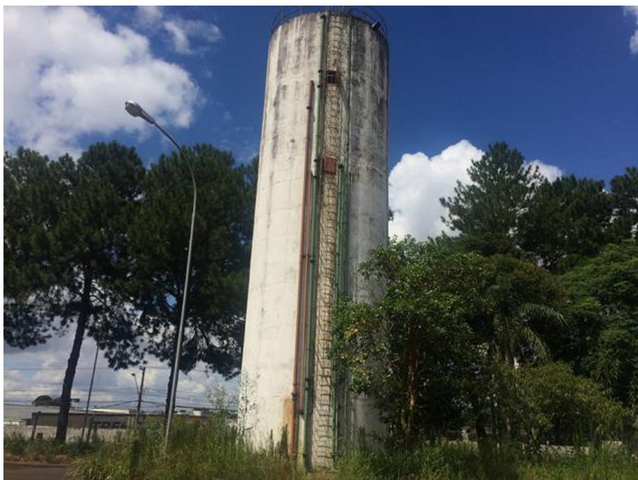
Vista da torre da caixa d'água.
