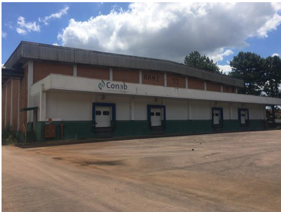
Vista Frontal do Armazém 2.
