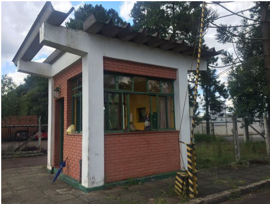
Vista da Guarita.
