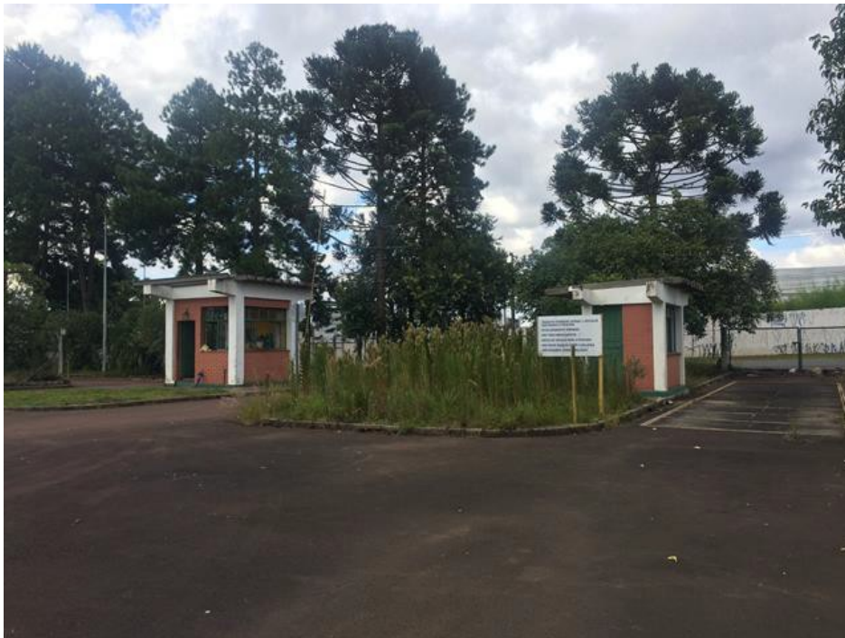
Vista dos portões de acesso de veículos
