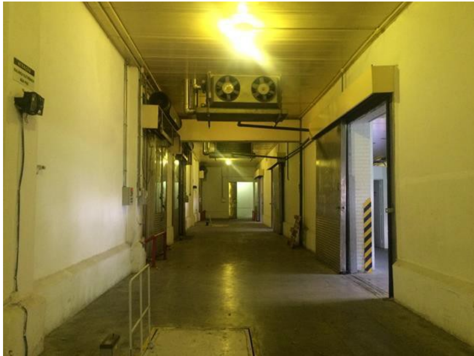
Armazém2 – corredor de acesso as câmaras.
