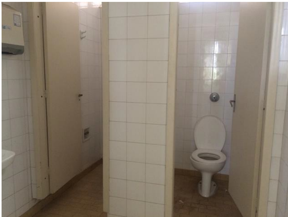
Administração – detalhe de um banheiro.
