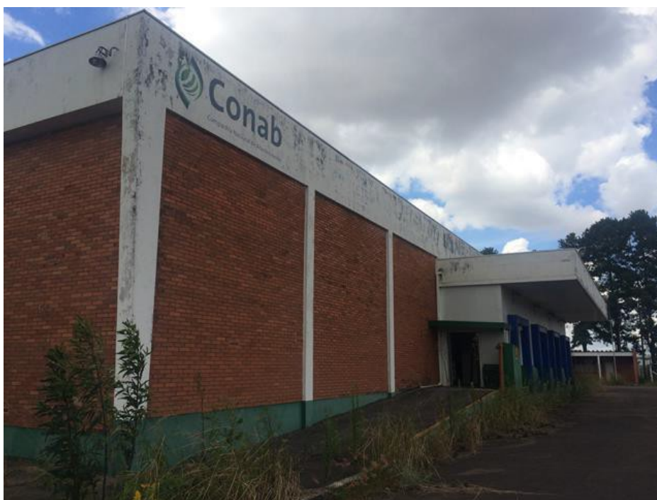
Vista frontal do Armazém 1.
