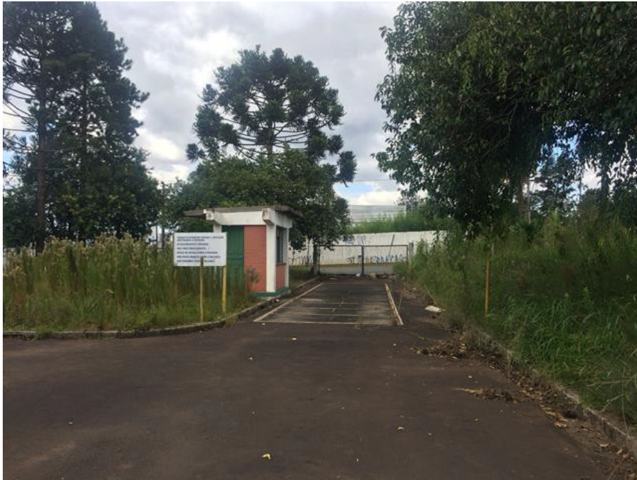
Vista da balança rodoviária.
