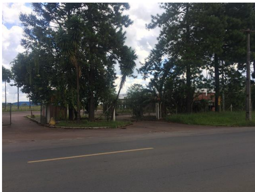
Vista frontal do imóvel.
