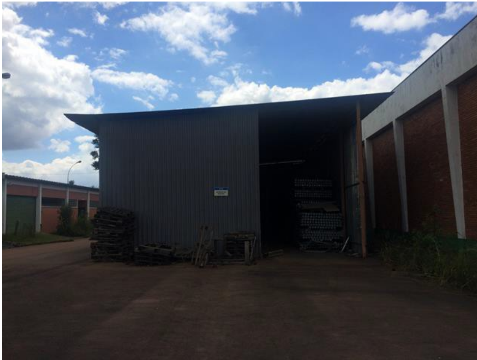
Vista do depósito de Paletes
